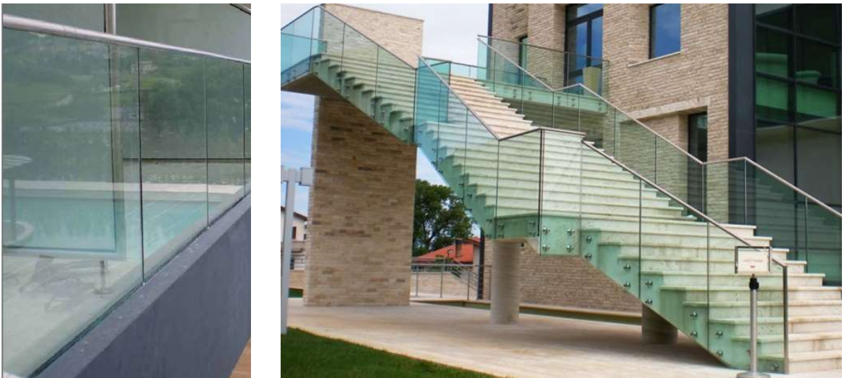
Fig. 30: Esempi di protezioni anticaduta in vetro (gruppo 2)
